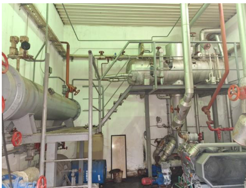
Pumpa za amonijak MPD i rashladni kompresorski sustav u klaonici
